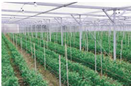
台風被害を大幅に減らしたほか、害虫被害の防止にも役立つ平張施設
