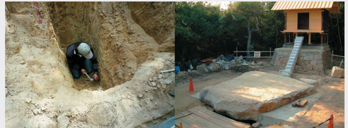
左：石室を手掘りしている様子。のみとハンマーを用いて柔らかい土の部分の削ぎ落としていく。右：巨石を設置した直後の様子。この後、巨石の上に拝殿が建つ。写真提供：よしもと正人 Left: The stone chamber being carved by hand. The soft earthen area is shaved off with a chisel and hammer. Right: Moments after the gigantic rock was placed. A worship hall was built on top afterwards. Photo courtesy: Masato Yoshimoto
