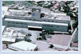
1991年2月 BML総合研究所 R&Dセンター竣工
