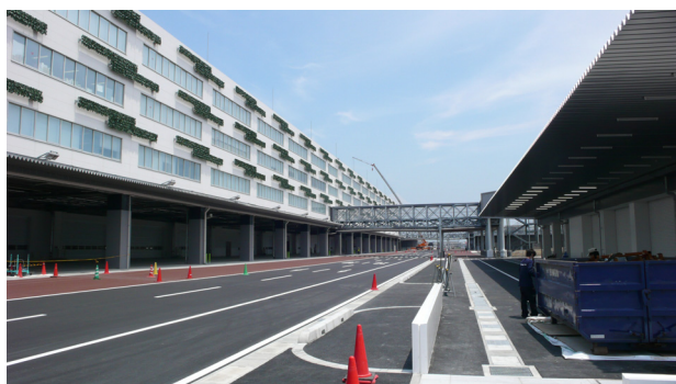
図8 第1国際貨物ビル外観
