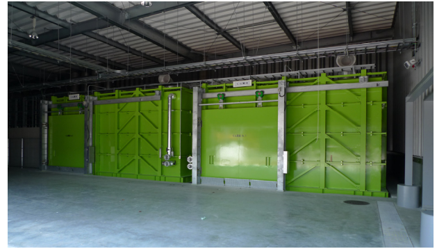
図12 生鮮棟内に配置された燻蒸庫
