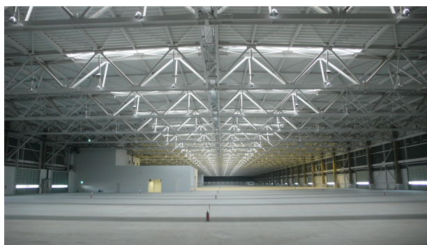
図9 第1国際貨物ビル 荷捌き場
