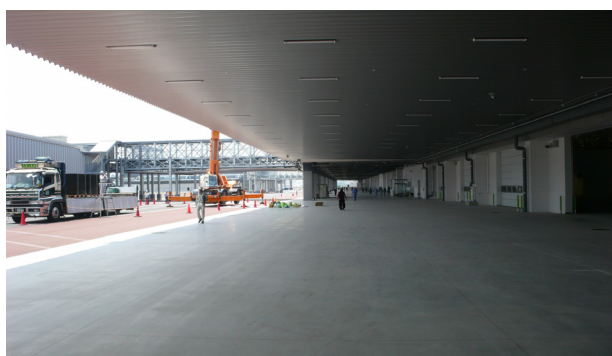
図10 第1国際貨物ビル トラックヤード
