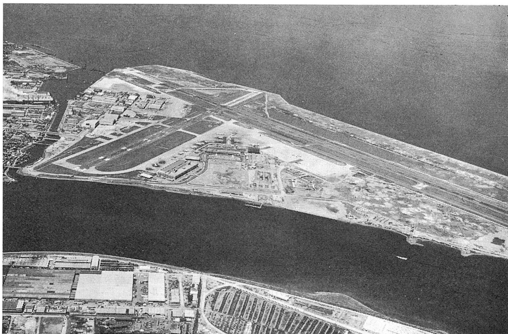
写真—5 昭和37年当時の東京国際空港の全景
