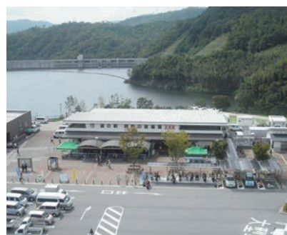
県営福富ダムと道の駅湖畔の里 福富
