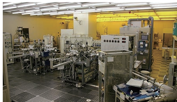
スーパークリーンルーム内
