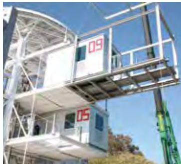
静岡事業所実験棟
