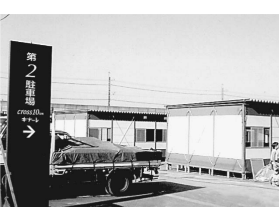
仮設住宅 道の駅「クロス10十日町」道の駅の駐車場に被災者支援住宅
