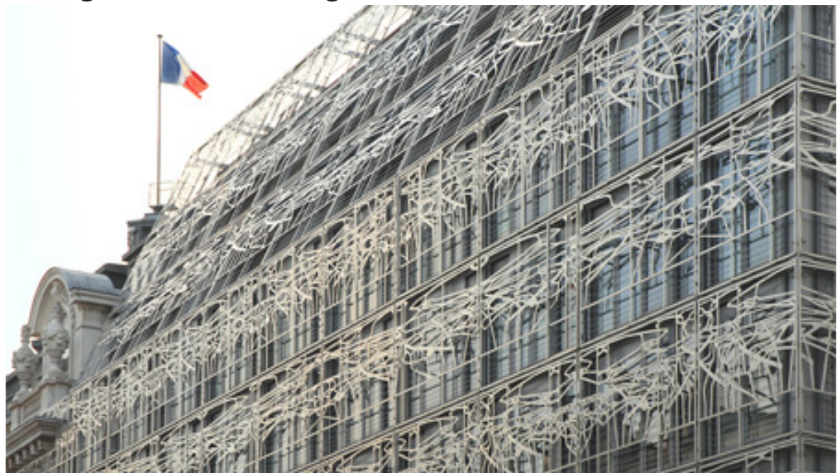
“les bons enfants”. francis soler, frederic drouot, michel desvigne. steel latticework facade.
