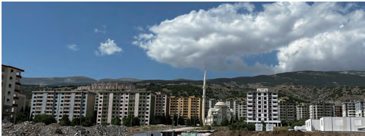
大震災後、倒壊は防止したが誰も住まない集合住宅群 トルコ・カフラマンマラシュ 2023.02.06 (撮影：関戸博高)
