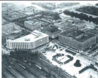
1993年の丸の内。手前に「東京中央郵便局」、奥に建設中の「明治生命館」。
