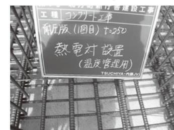
⑫熱電対センサー設置状況
