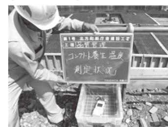
⑪コンクリート養生温度測定状況
