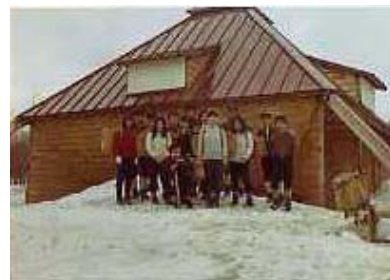
1970年4月1回目の山小屋 まだ庭側も小屋内部が広がっていない
