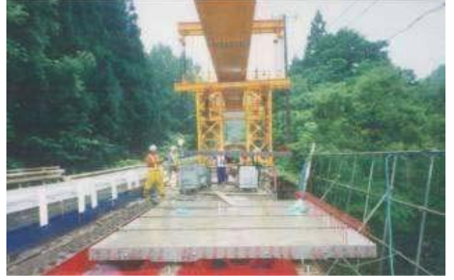
木狭間橋 施工写真
