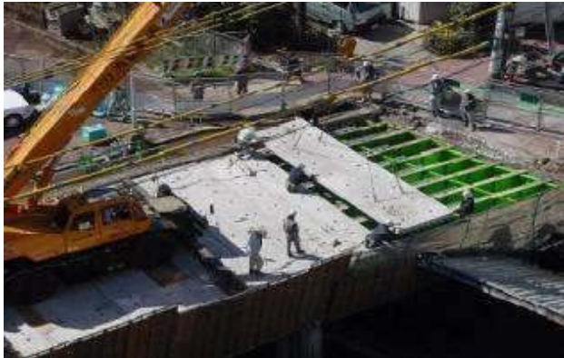
新富橋 施工写真
