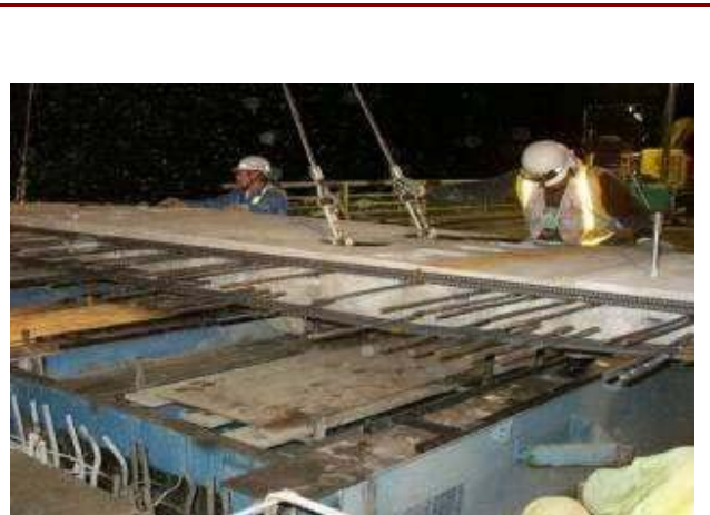
大川橋 施工写真
