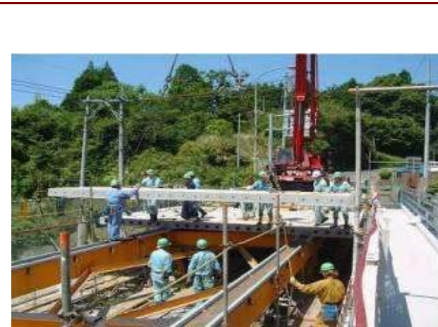
松山橋 施工写真
