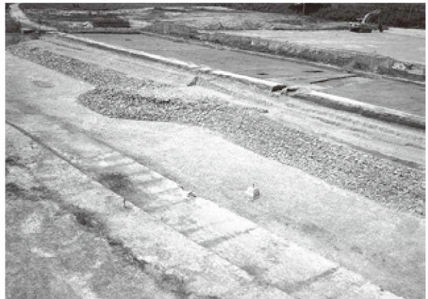
写真3 第4・5次調査石積み護岸と水制C(南東から)
