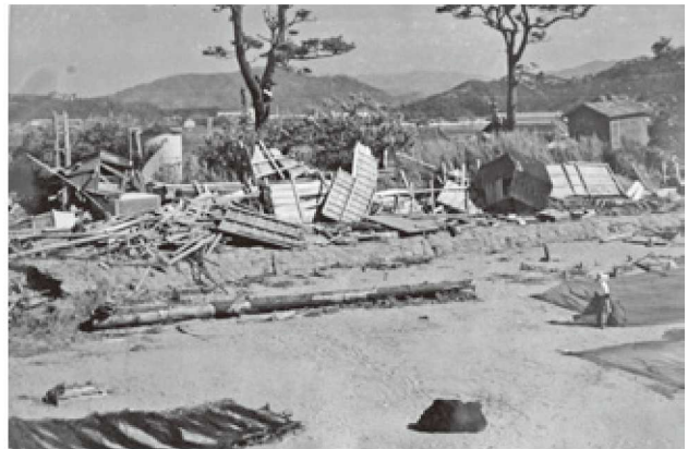
写真7 第2室戸台風による被害(西から)
