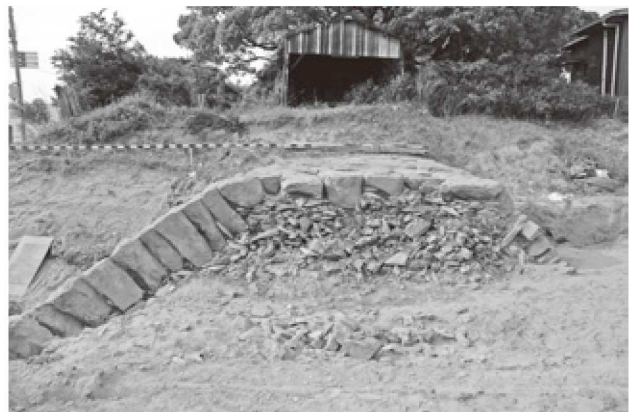
写真4 石堤上部断面（南から）
