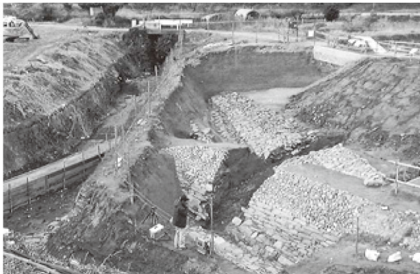
写真4 第6次調査2種類の石積み護岸(南東から)
