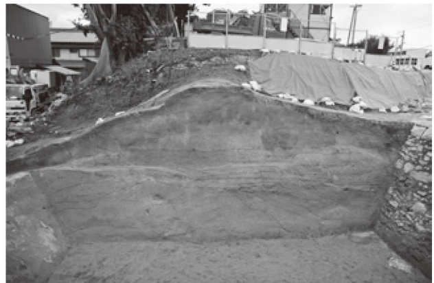
写真6 土堤断面（北から）
