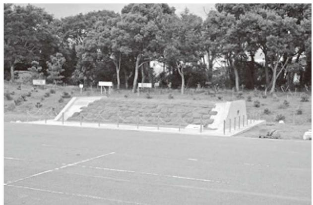
写真9 中堤防石堤移築復元状況
