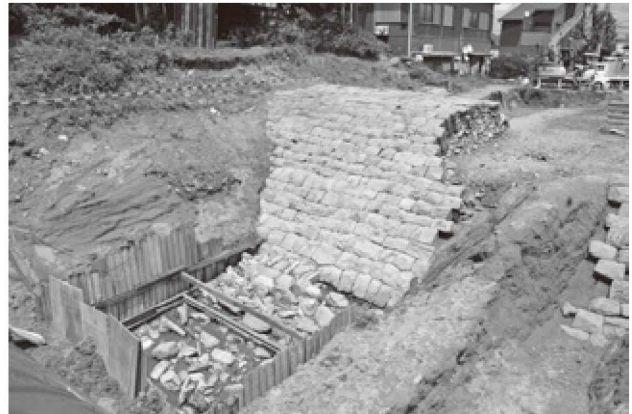
写真5 石堤と海側に設置された石敷（南西から）
