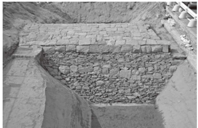
写真3 石堤裏法の石積み（東から）
