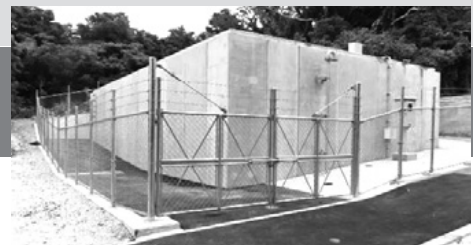
安谷屋第2地区ファームポンド施設
