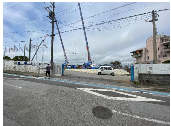
▲建設中のふれあい交流センター （宜野座小学校裏手の村道中学校線より）
