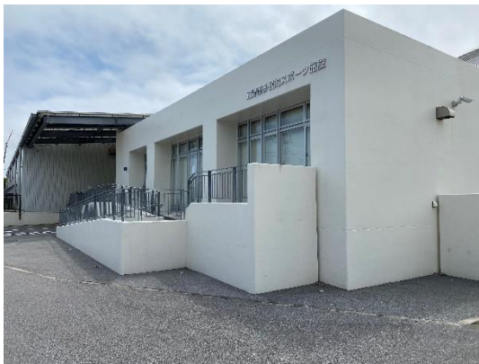
▲宜野座村多目的スポーツ施設
