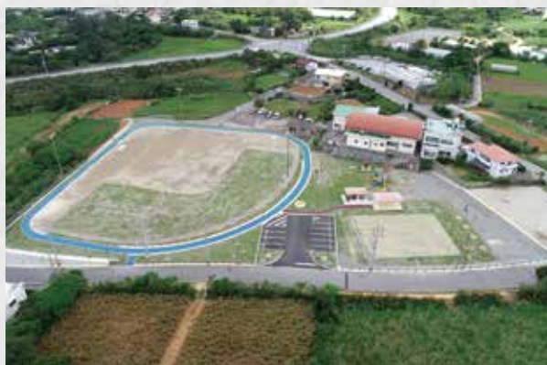
福山区公園改修工事
