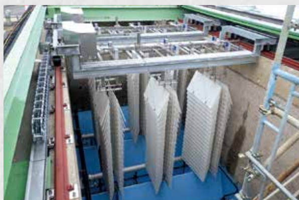
福山浄水場凝集沈殿池改修工事(その3)
