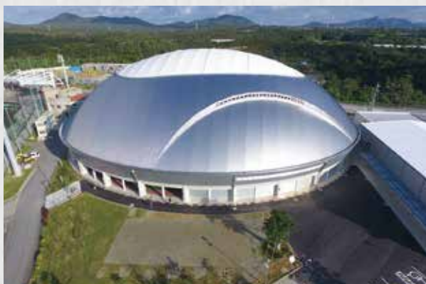
宜野座村多目的広場建設事業
