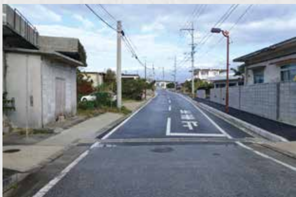
高松進入路改良舗装工事
