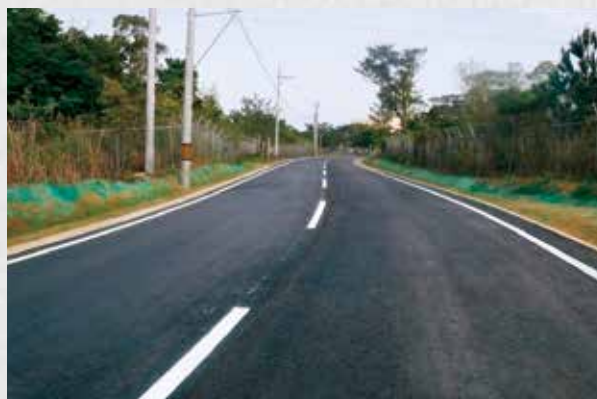
福山進入路整備工事
