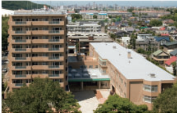
一般棟(左)と介護専用棟(右)からなる最新の施設(光ハイツ・ヴェラス真駒内公園)
