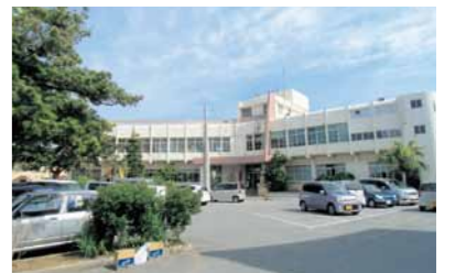
▲西原町役場旧庁舎(本庁舎)
