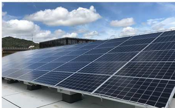
<太陽光発電パネルの設置>
