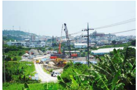
モノレール新駅周辺地区
