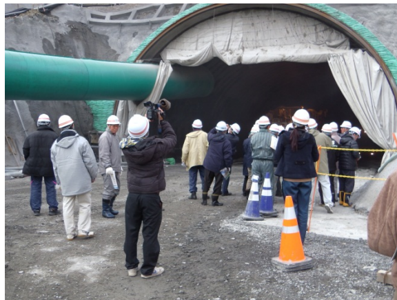
▲現場見学状況
