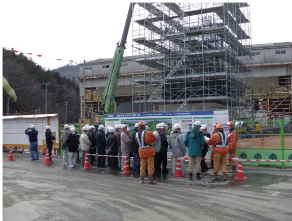
▲現場見学状況
