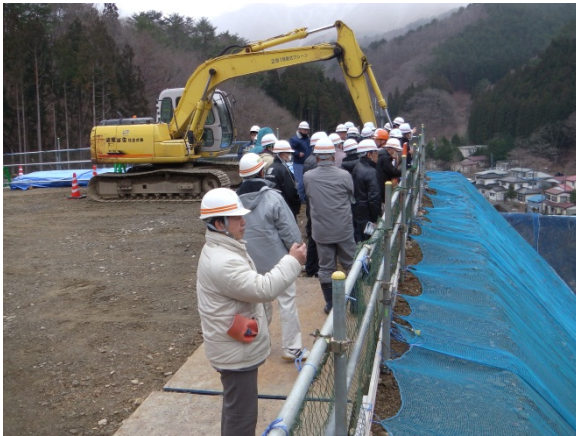
▲現場見学状況
