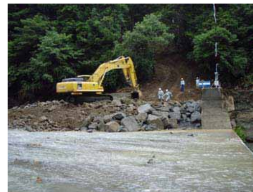
▲沼倉裏沢地区砂防えん堤袖部保護
