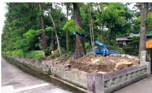
修復工事の様子
