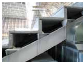
PC段床を利用したスリット断面
