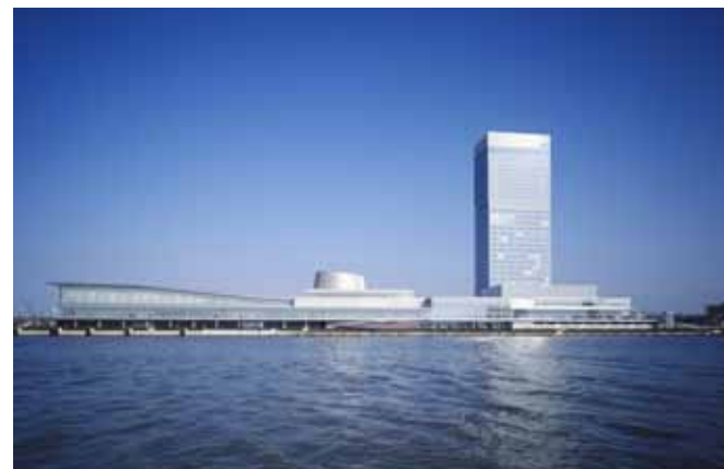
新潟国際コンベンションセンター(朱鷺メッセ) 株横総合計画事務所 新潟県 / 27,727㎡ SRC-4F / 2002年 写真:北島俊治
