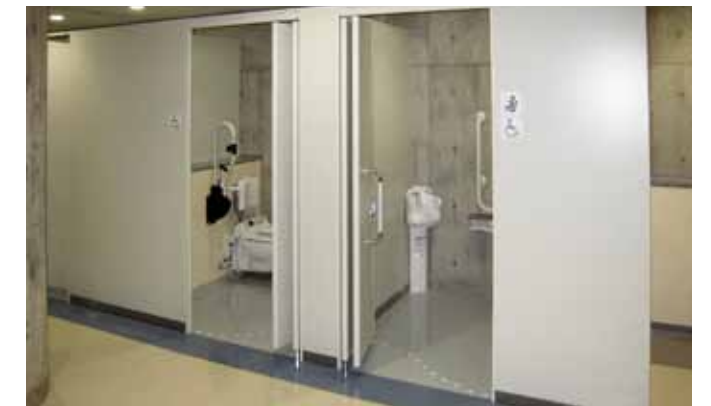
大型トイレブース
