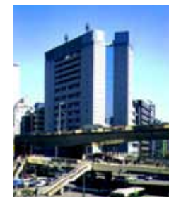
警視庁渋谷警察署庁舎 株東畑建築事務所 東京都 / 17,000㎡ RC-B4-14F / 1994年
