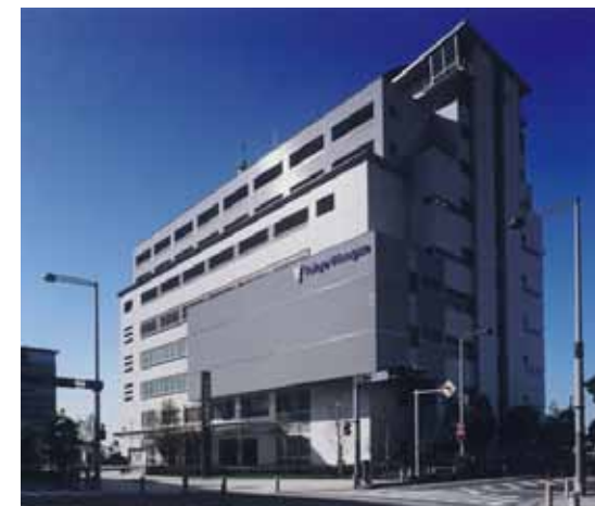
臨港警察署 株東畑建築事務所 東京都 / 16,746㎡ SRC-B1-9F / 2005年
