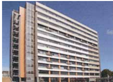
東北大学工学系総合研究棟 東北大学 宮城県 / 20,600㎡ SC-B1-13F / 2002年
