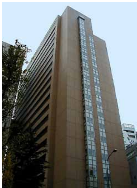
東京医科歯科大学臨床研究棟 東京医科歯科大学 東京都 / 29,100㎡ SRC-B4-19F / 1999年
