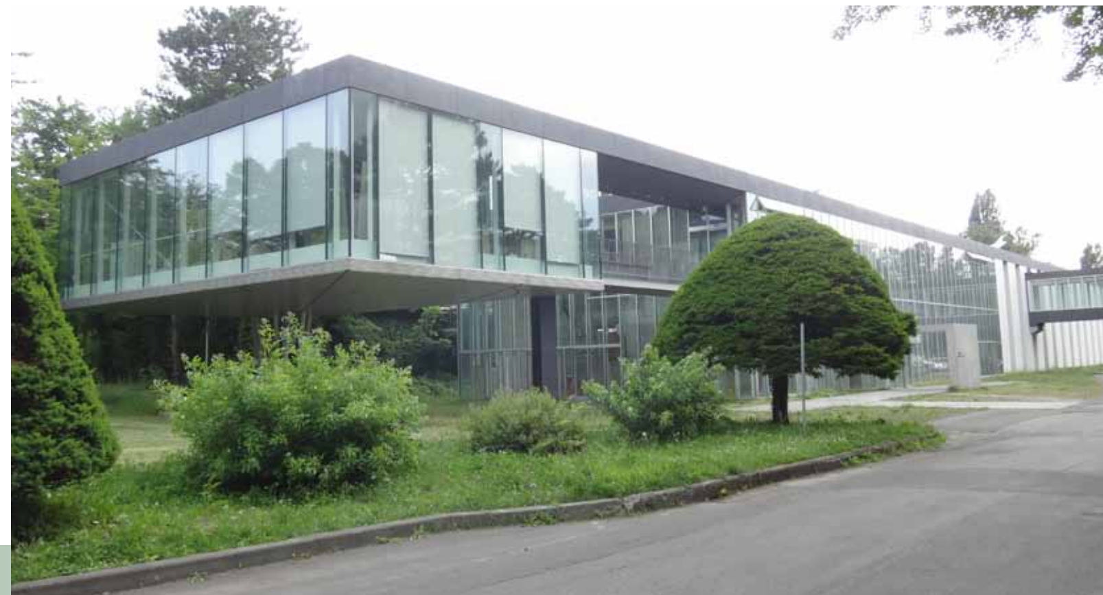
北海道大学工学部共用実験棟 北海道大学 北海道 / 2,340㎡ RC-B1-2F / 2007年
