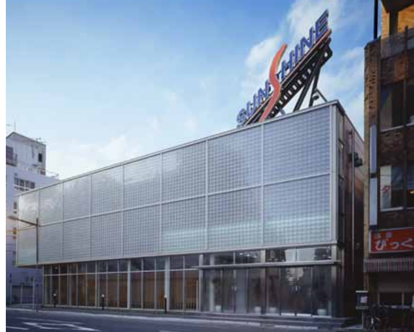
浅草ジェイズビル 株上西建築都市設計事務所 東京都 / 2,400㎡ SRC-S-B1-2F / 2003年 写真:北島俊治
