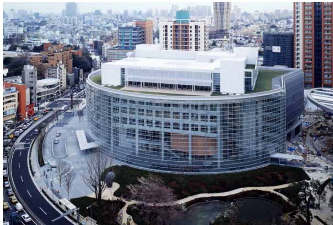
テレビ朝日新本社ビル (株)横総合計画事務所 東京都 / 73,400㎡ SRC-SC-B3-8F / 2003年 写真:北島俊治
