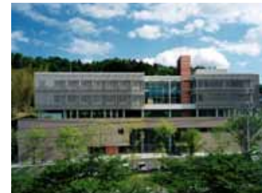
福島県男女共生センター 株横総合計画事務所 福島県 / 6,999㎡ RC,SRC,S-5F / 1997年 写真:北島俊治
