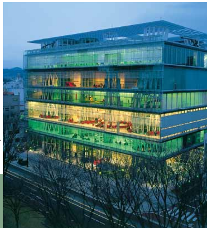
せんだいメディアテーク 株伊東豊雄建築設計事務所 宮城県 / 21,654㎡ S・一部RC-7F / 2000年 写真:宮城県観光課
