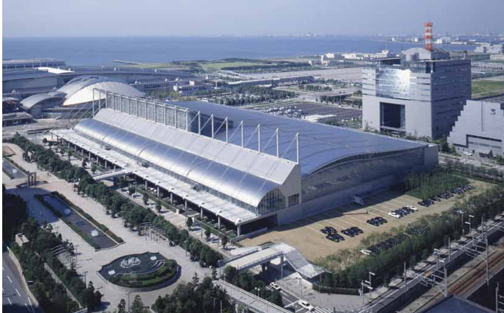
幕張メッセ北ホール (日本コンベンションセンター) 株横総合計画事務所 千葉県 / 33,410㎡ S・SRC-2F / 1996年 写真:北島俊治
