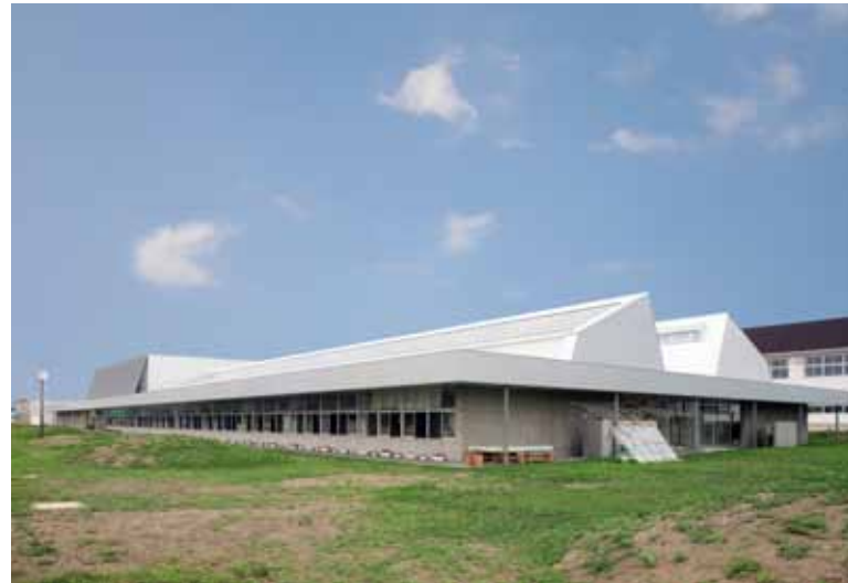
写真-1 建物外観
