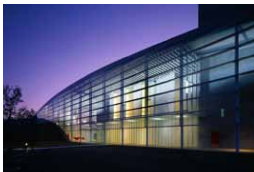
大社町民文化会館・図書館 株伊東豊雄建築設計事務所 島根県 / 6,500㎡ SC・RC (一部)・3F / 1997年 写真:大橋富夫建築写真事務所
