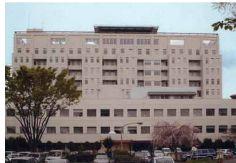
千葉大学医学部附属病院病棟 千葉大学 千葉県 / 20,210㎡ RC, SRC-B1-11F / 2004年
