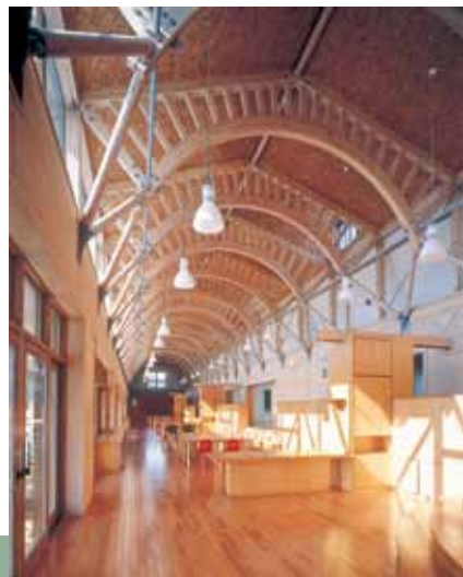
金山町立明安小学校 ㈱小沢明建築研究室 山形県 / 2,300㎡ RC+WC-2F / 1999年 写真: 篠澤建築写真事務所
