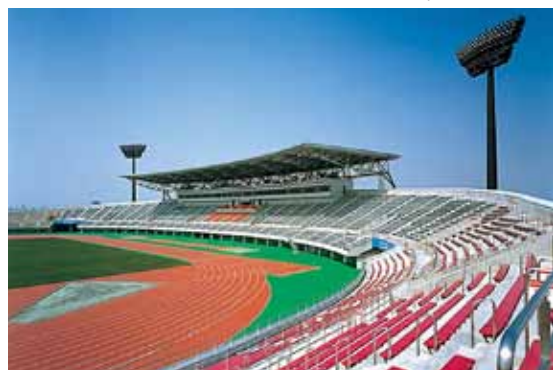
熊谷スポーツ文化公園陸上競技場 株式会社建築事務所 埼玉県 / 15,718㎡ RC-4F / 2002年
