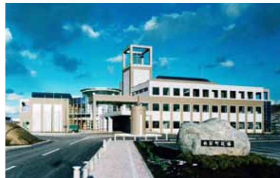
新冠町役場庁舎 株日本技建 北海道 / 4,700㎡ RC-3F / 1997年
