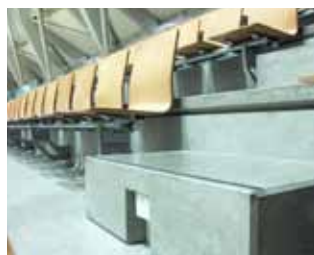
客席下吹出し「PC段床スリット吹出し」
