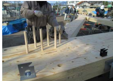
LVL 材フレームの組み立ての様子
