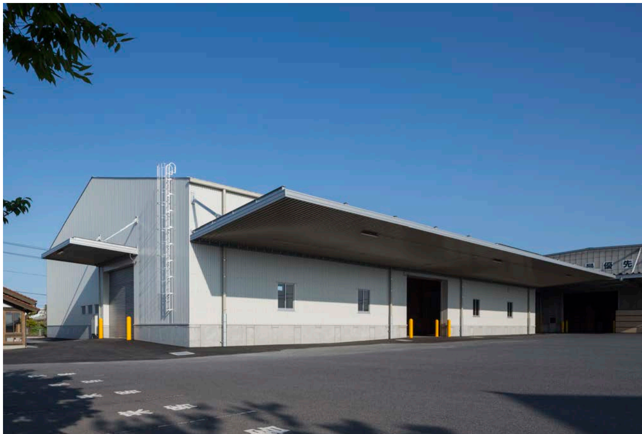
倉庫棟の全景
