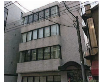
既存RC造ビルの現況
