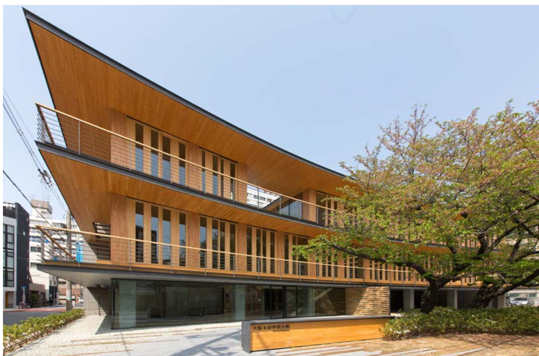
道路に開けた面には木製建具を採用し、木の表情にあふれる建物
