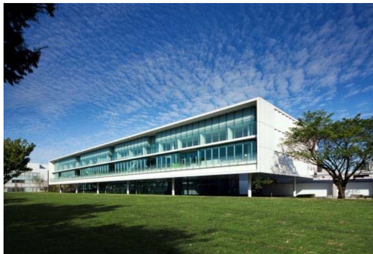
大林組技術研究所本館 テクノステーション
