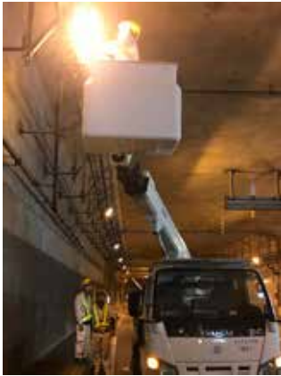
うみそらトンネル内の照明設備工事
