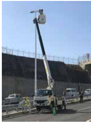
道路の照明灯工事
