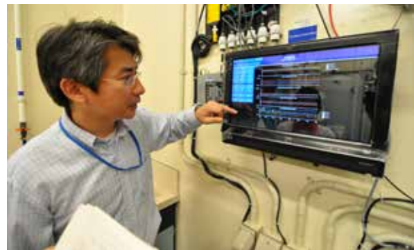
タッチパネル製の制御システム
