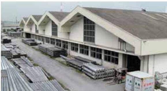
整然と資材が並べられている「海邦工場」
