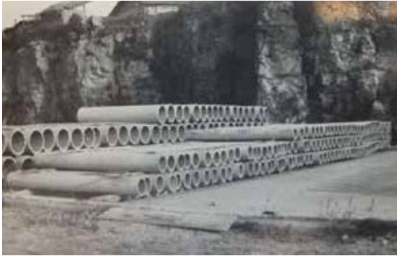
(創業当時)ヤードに積まれたヒューム管製品
