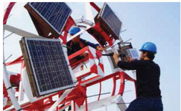
海上保安庁の海洋浮標に海中に沈める機器を取付け
