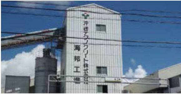
中城湾港新港地区工業用地に立地する「海邦工場」
