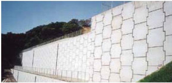
コンクリートパネルを使った擁壁工事
