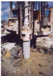
RODEX工法(回転埋設)による施工
