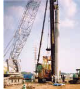
中掘り工法による施工
