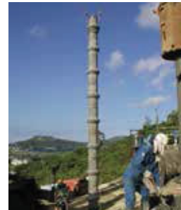
節付きパイプを使った施工
