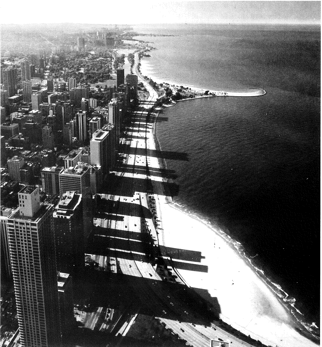
ミシガン湖畔に建つシカゴ高層ビル(筆者撮影)
