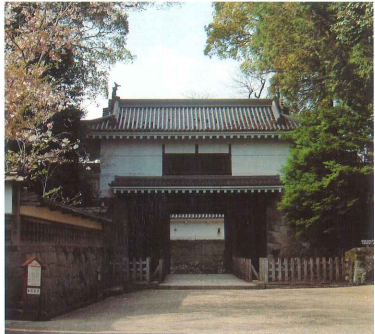
飢肥城 天正16年から280年間、明治初期まで伊東家居城。大手門は樹齢百年をこす飢肥杉を用いて昭和53年（1978年）7月に復元された。
