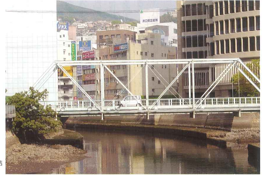
側面から見た出島橋 繊細なピントラス構造と部材を結合する大きなボルトが見える
