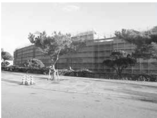
改修工事風景（北側）
