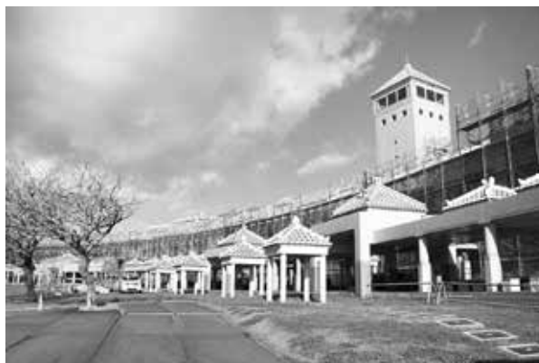
改修工事風景（南側）
