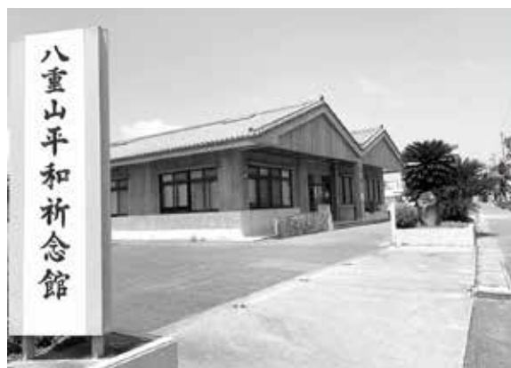
八重山平和祈念館外観
