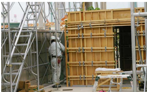
組み立てた型枠のチェックを行う
