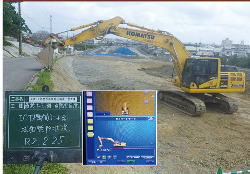
「平成30年度与那原補強土壁工事」
