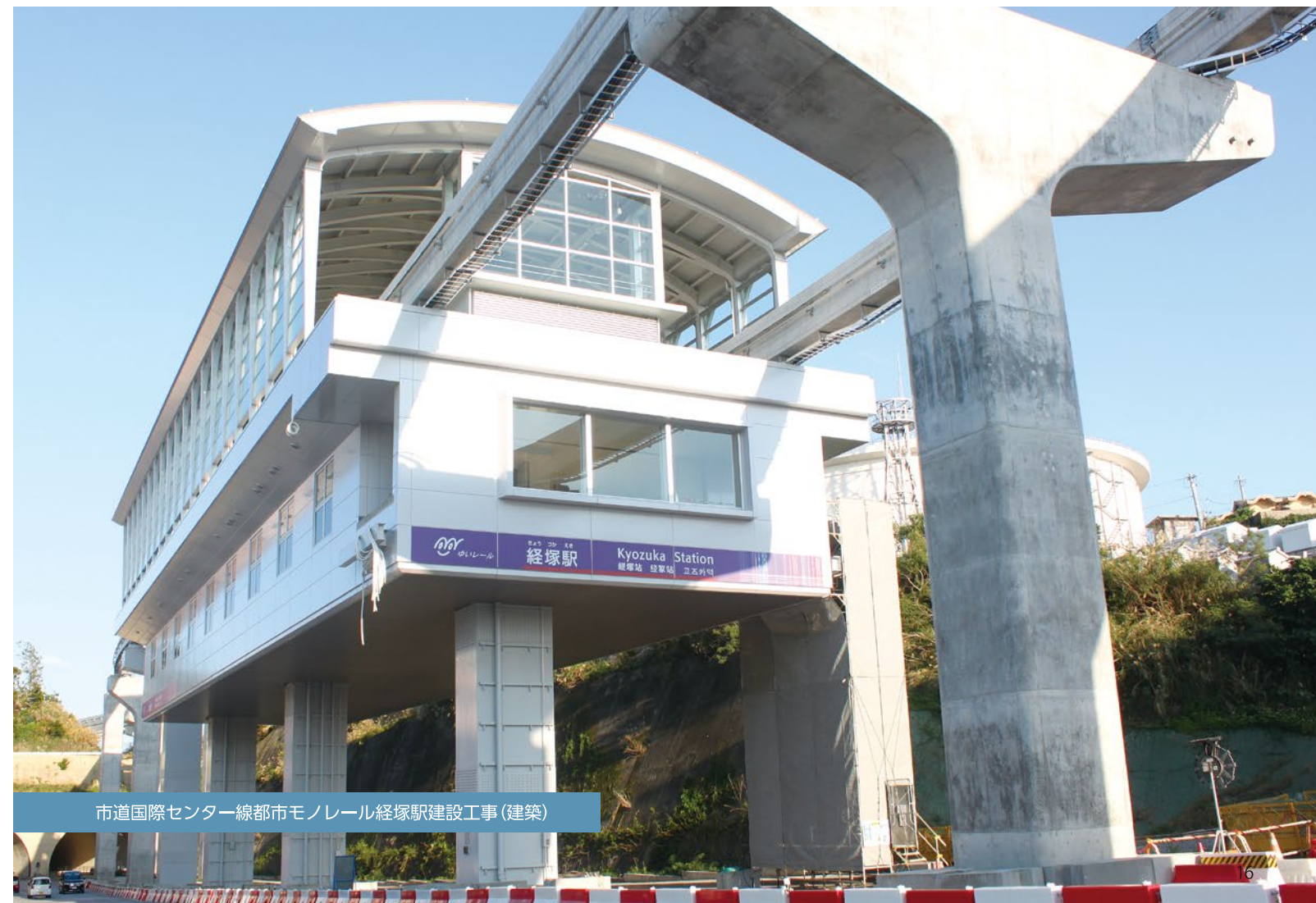
航空機整備基地新築工事（事務所棟建築2工区）
