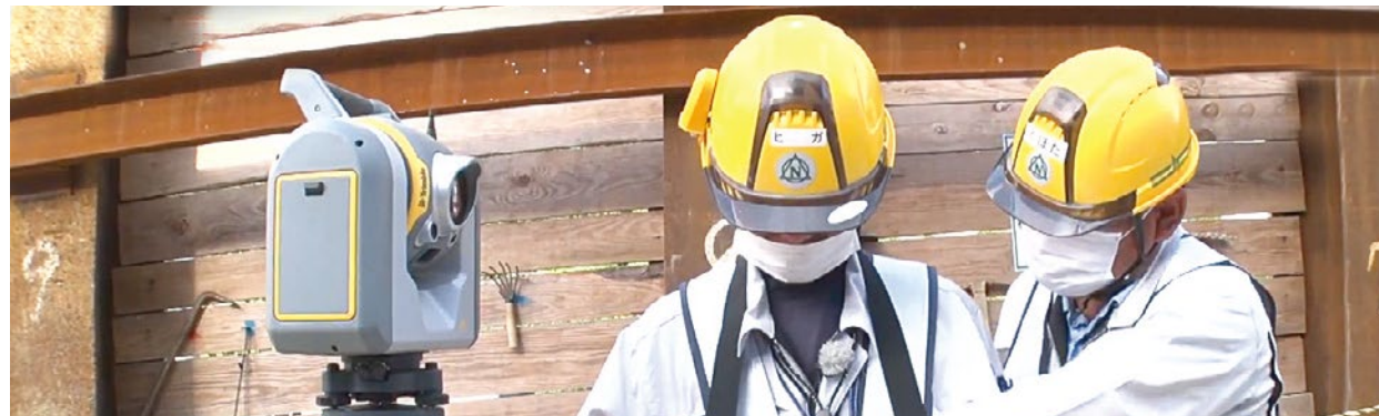
〔浦添工業高校Bブロック法面对策工事(R1)〕
