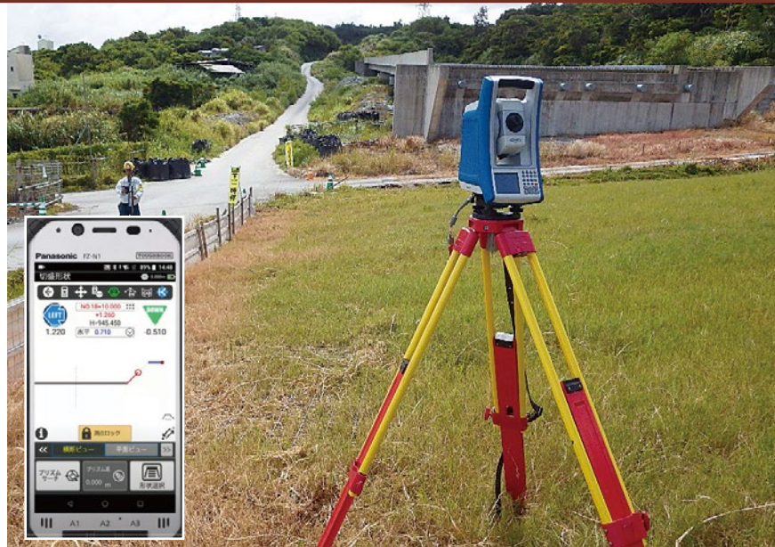
「平成30年度与那原補強土壁工事」
