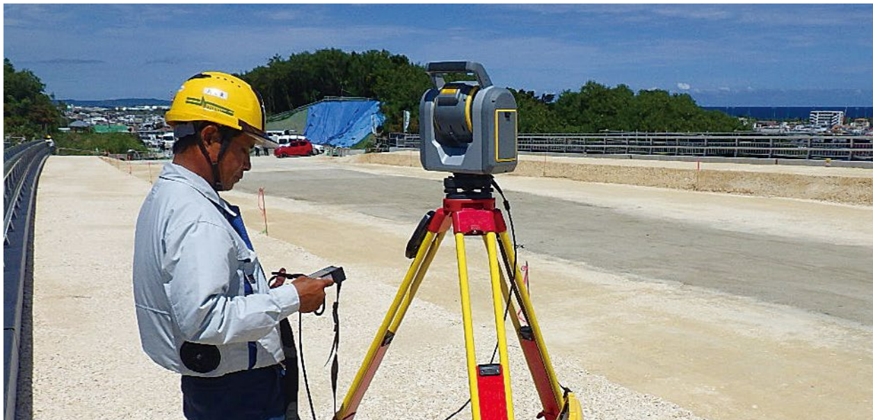
〔平成30年度与那原補強土壁工事〕
