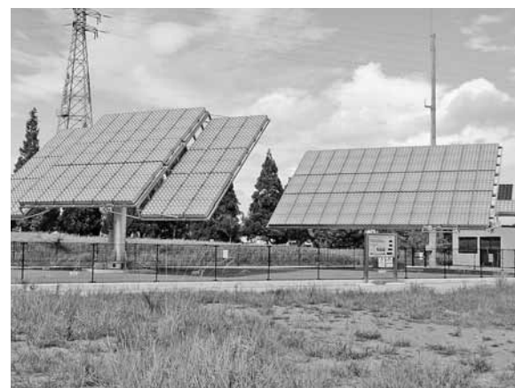
木花キャンパスに設置された産学共同研究用の集光型太陽光発電システム（集光型では国内最大級の14kW×2機、太陽自動追尾型）
