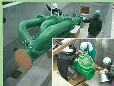
地下に埋設した弁室内に定圧定流量弁を設置します。
