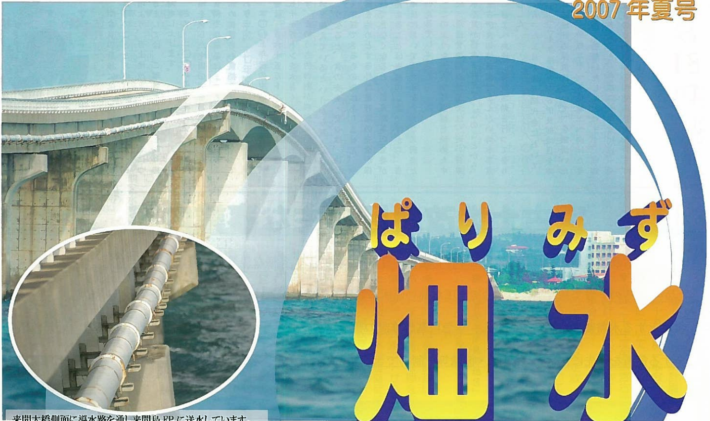
来間大橋側面に導水路を通し来間島FPに送水しています。
