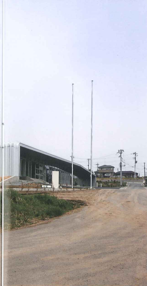
南東外観。地上まで伸びる折板屋根と、深い軒のテラス連窓を組み合わせることで水平線を強調。屋根勾配は1/30 (特記以外の写真: 上田 宏)
