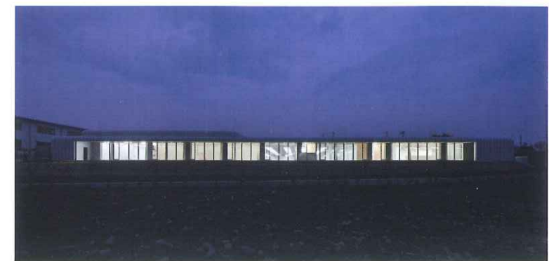
南の庭園から見た夜景。水平に伸びる連窓が折板屋根によって枠取られ、工場の水平なシルエットを強調
