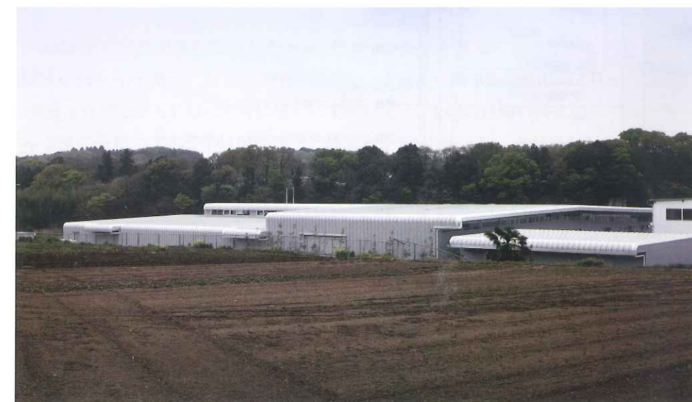
北東からの外観。内部の製造ラインに合わせた高さの異なる折板屋根が、緑の背景に浮かび上がっている
