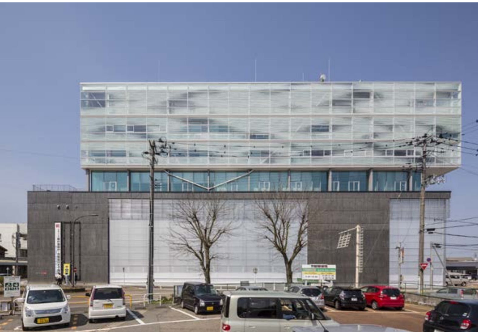
30m スパンを可能にした吊橋のようなサスペンション構造
