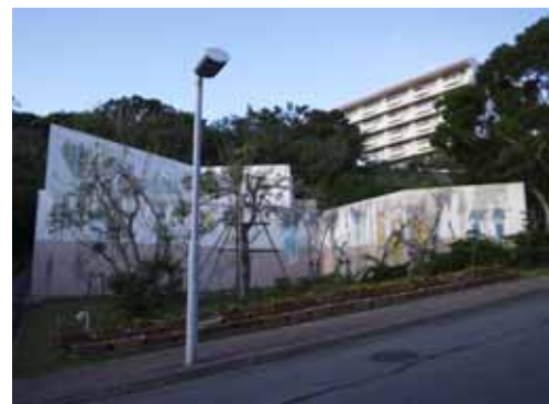
写真 4.1 貯水関係施設
