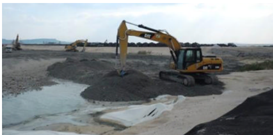
図-15 バックホウによる敷均し
