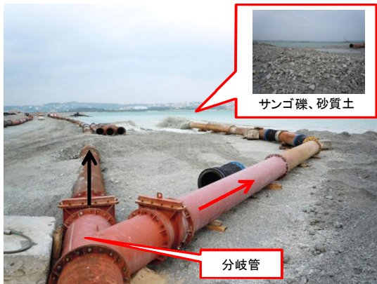
図-14 砂質土砂 揚土状況
