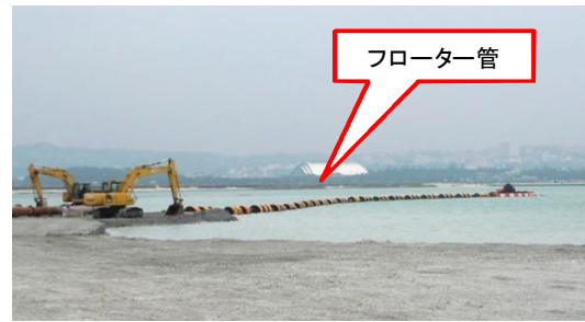
図-16 粘土質土砂 揚土状況
