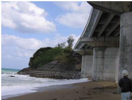
c) A1 橋台側の護岸と主桁の位置関係
