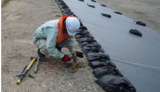
図-13 堤体のシートと観測機器設置
