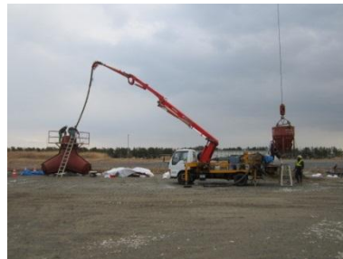
写真-2 ポンプ車による圧送(消波ブロック)
