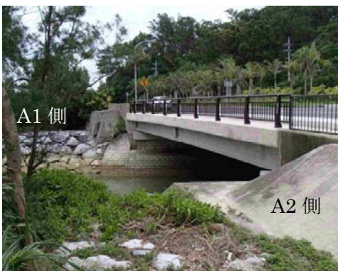
写真1 対象橋梁全景
