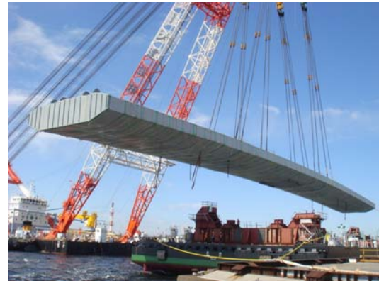
写真-3：大ブロックの積み込み状況
