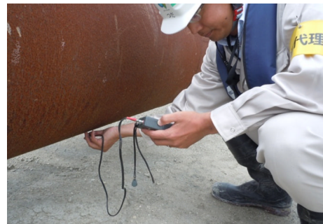
図-10 超音波肉厚計による排砂管点検
