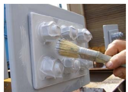
b) 注入後の刷毛による表面成型
