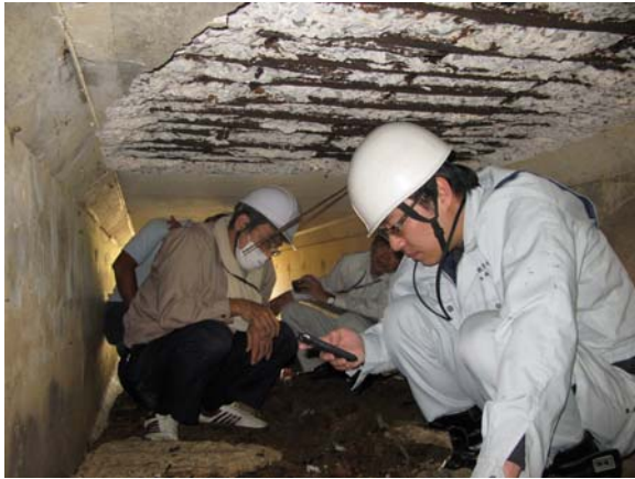
写真4 現場調査状況
