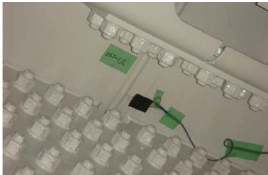
写真-4：ひずみゲージ設置状況
