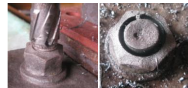
(a) コア抜き前 (b) コア抜き後 写真2 コア抜き作業
