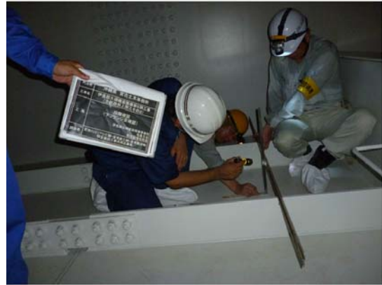
写真-6：残留変位の確認状況
