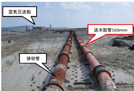
図-20 送水配管の設置状況
