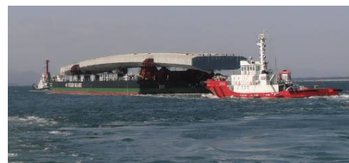
写真-1：No2ブロック台船輸送状況
