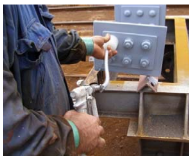
a) エポキシ樹脂塗料注入状況
