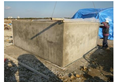
写真-3 根固めブロックの出来栄え
