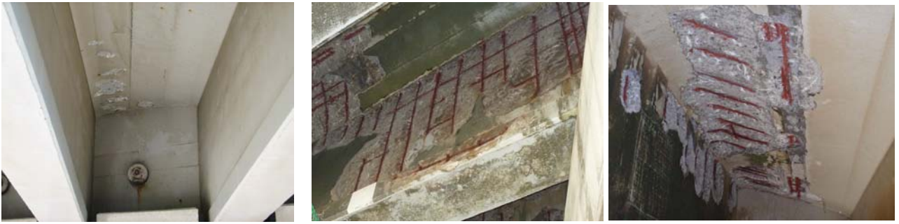
a) P2-P3 間の損傷状況
