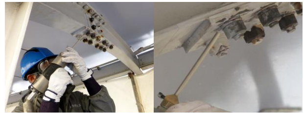
写真2 SZ工法現場施工状況
