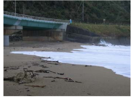
d) A2 橋台側の護岸と主桁の位置関係
