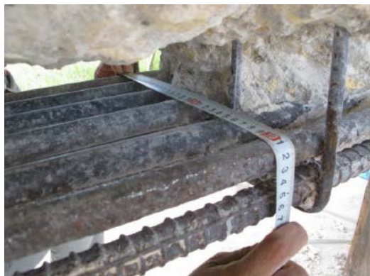
写真-2 W-1 の配筋状況
