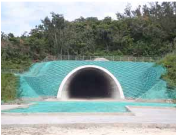
写真 2.1 終点側坑口全景
