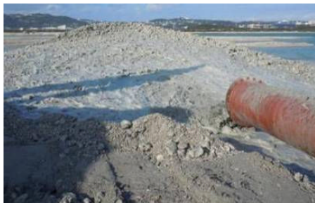
図-8 サンゴ塊堆積状況(吐出口)
