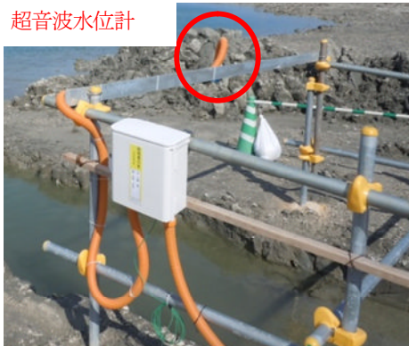
図-17 超音波水位計設置状況
