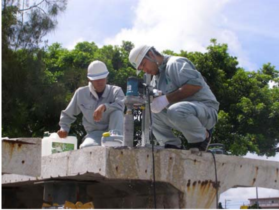
写真8 RC桁のコア採取状況
