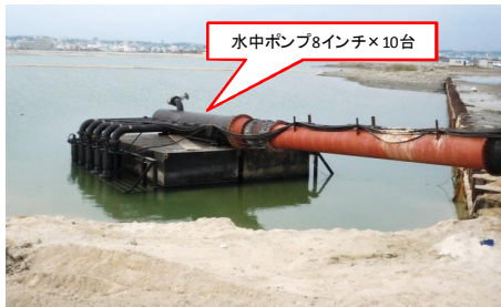
図-19 大型水中ポンプ使用
