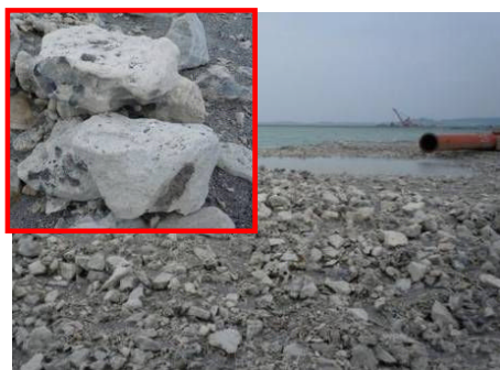
図-9 揚土状況(サンゴ塊破碎圧送後)
