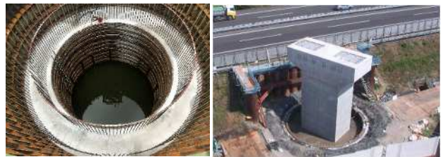
写真-2 基礎完了全景 写真-3 橋脚完了全景
