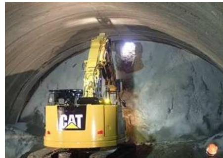
写真-3 月浦トンネル(Ⅱ期線)の貫通時の様子
