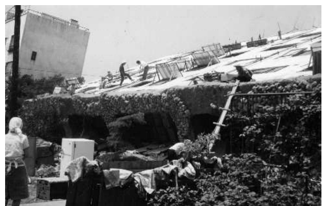
写真-1 県営アパートの液状化被害状況 文献2)
