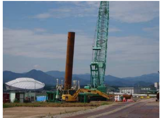
写真-1 斜杭施工状況
