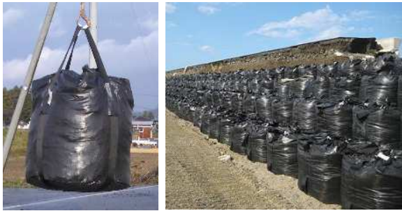
図-9 耐候性大型土のう
