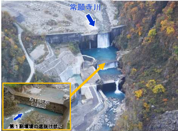
▲サブ谷砂防堰堤補強対策
