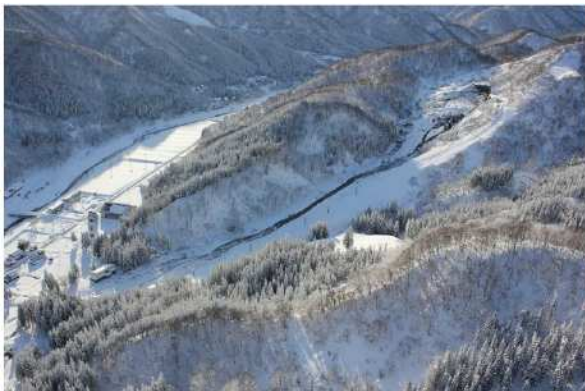
写真－1 土砂災害全景写真（2017 年 1 月 17 日富山県撮影）
