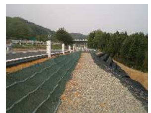
②仮復旧後（着工後5日）
