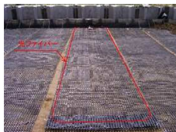
図-8 センサー入りジオテキスタイルを使用した補強土壁
