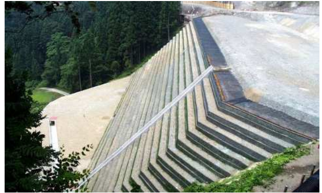
図-4 利賀ダム工事用道路
