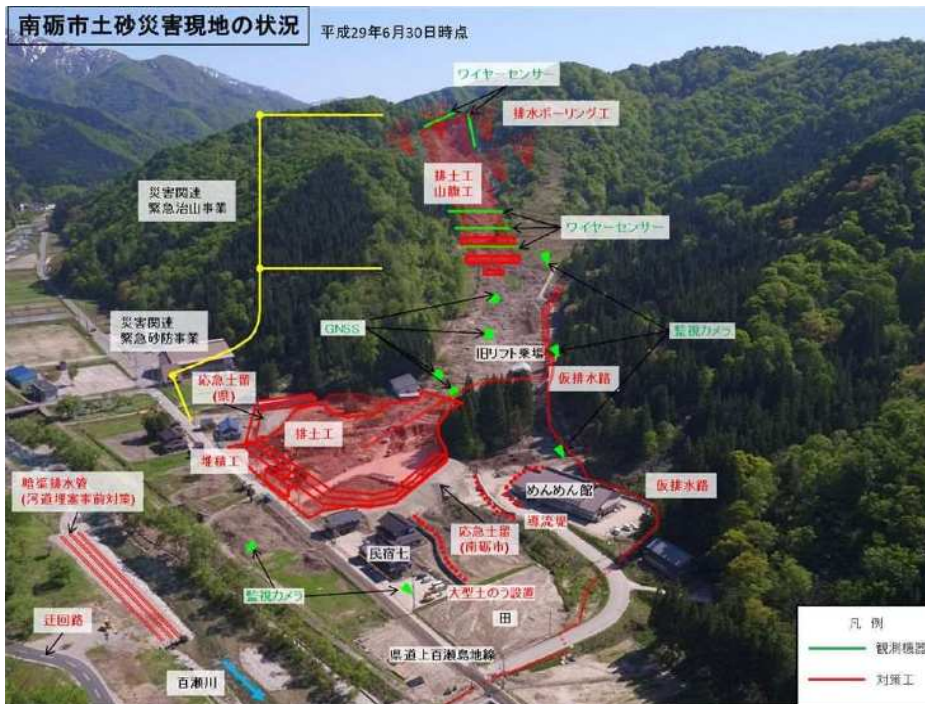
写真－4 災害関連緊急治山・砂防事業の全景（富山県）
