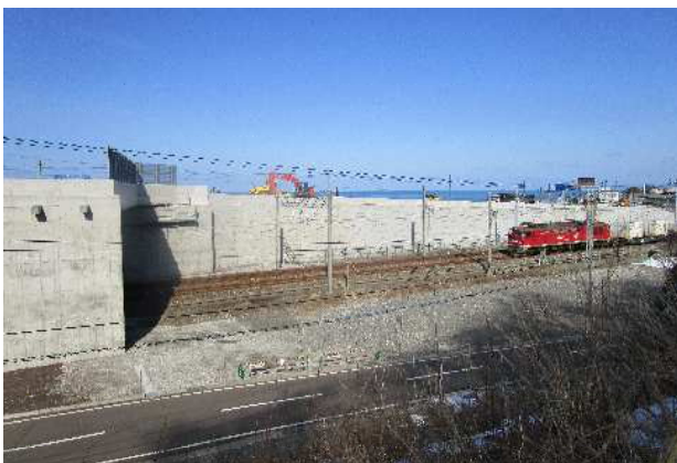
図-3 能生大橋付替道路他工事
