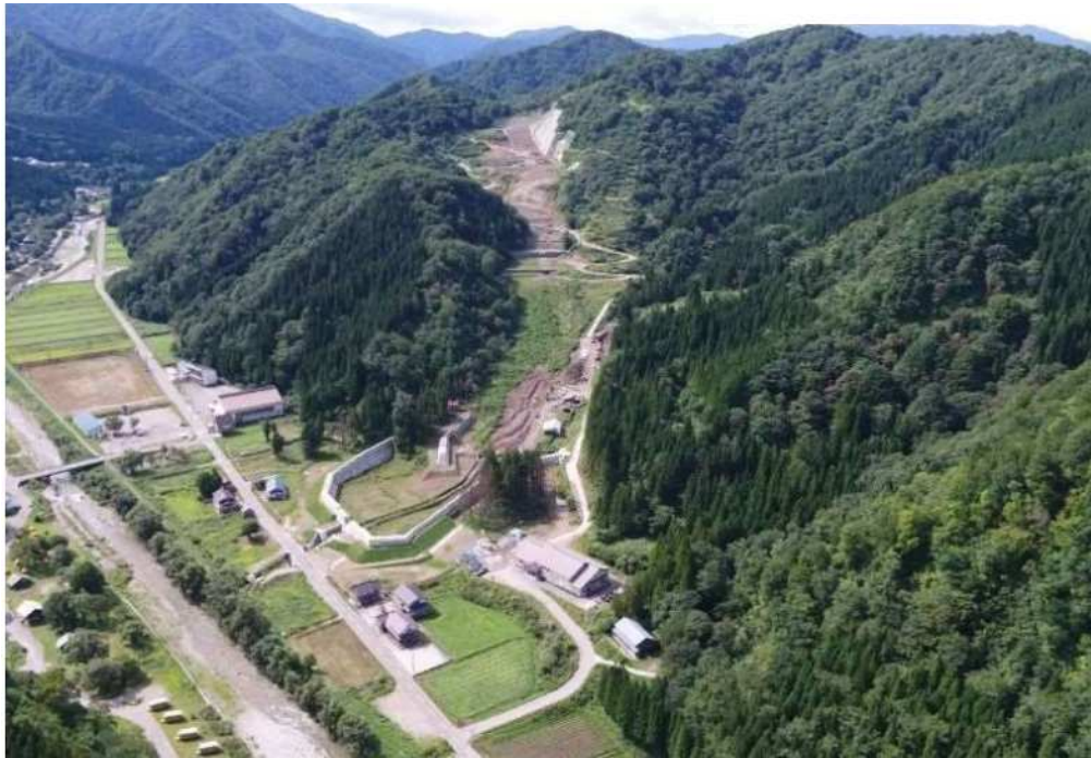
写真－5 2019年9月5日における現地の状況（富山県撮影）
