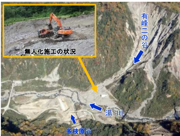
▲有峰二の谷崩壊地
