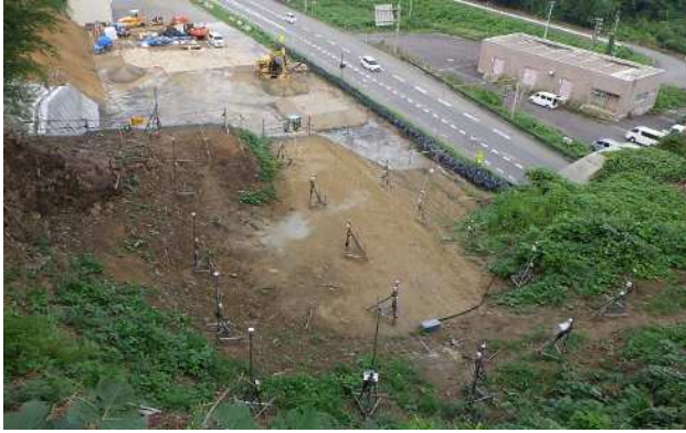
図-7 GNSS 地盤変位計設置風景
