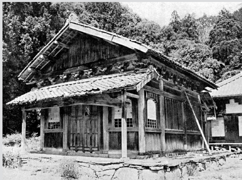
図3 | 天恩寺仏殿(岡崎市)修理前の外観
