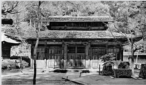
図2 | 定光寺本堂(瀬戸市)修理前の外観
