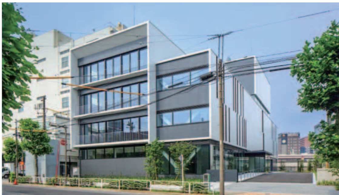
NTTファシリティーズ新大橋ビル
