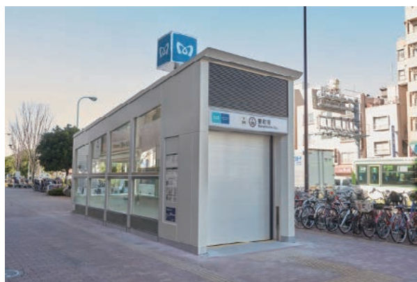
写真2 防水シャッター設置例
