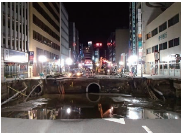
④流動化処理土投入
