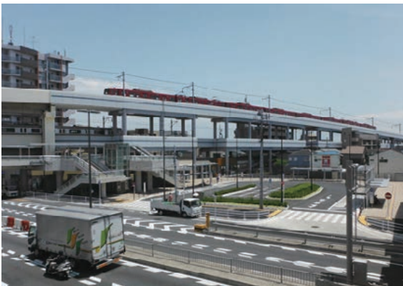
京急蒲田駅付近連続立体交差事業
