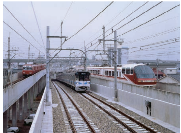
犬山線と地下鉄鶴舞線との相互直通運転開始
