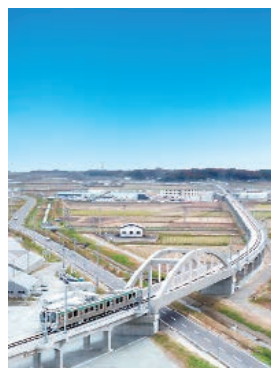
写真1 常磐線の復旧工事
