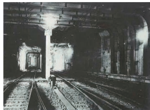
押上地下鉄工事現場
