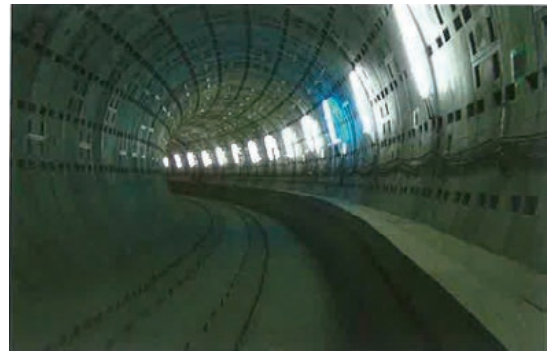
仙台市地下鉄東西線連坊工区
