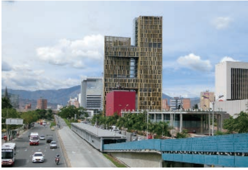
写真-14 BRT 1号線のプラサ=マヨール停留所。BRTの専用レーンがよくわかる。(2016年9月27日)
