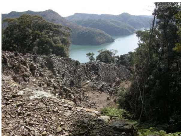
金田城跡・南東角石塁が雄大に残る
