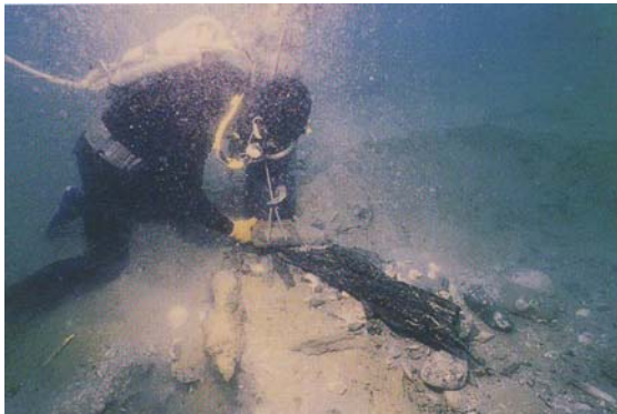
海底作業、水圧と空気圧を利用して土砂を吸い上げる
