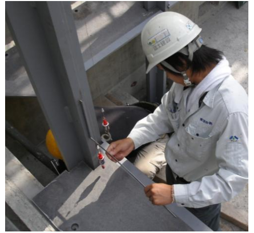
↑十字柱の立てり検査
