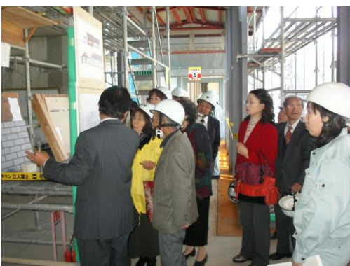
↑写真上より: 入口スラブの杉板へ、剥離剤を塗る。／杉板に塗る剥離剤の実験／入口スロープ傾斜確認の実験／建設中に行われた見学会の様子。色々な見本が並べられた。
