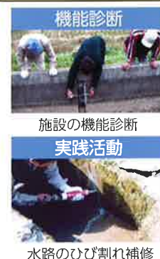
水路のひび割れ補修
