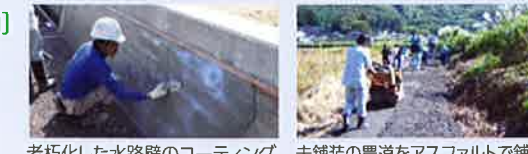
老朽化した水路壁のコーティング
