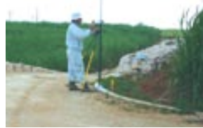
RTKによる基準点測量(4級)
