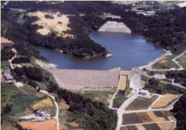
長浜ダム全景(写真 長浜ダム工事誌より)
